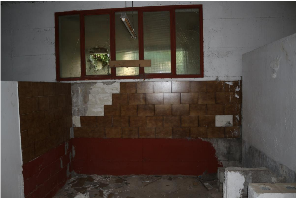
FOTO n°10. - visione interna immobile – corpo principale
