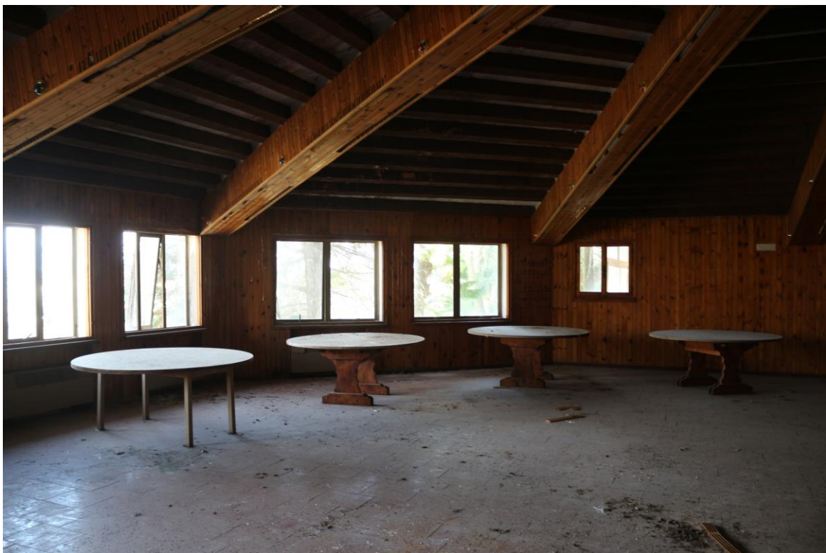
FOTO n°12. - visione interna immobile – corpo principale
