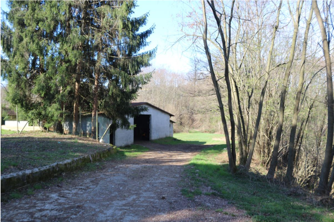
FOTO n°17. - visione esterna immobile – corpo staccato
