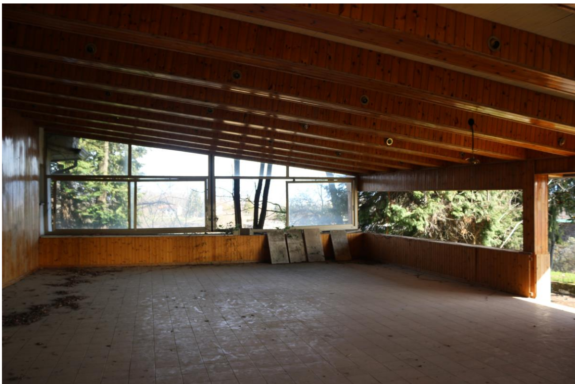
FOTO n°8. - visione interna immobile – corpo principale
