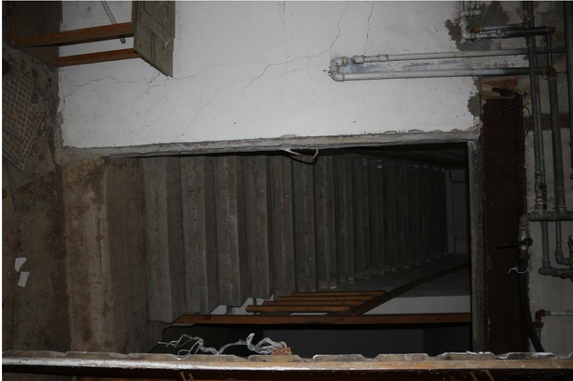
FOTO n°11. - visione interna immobile – corpo principale
