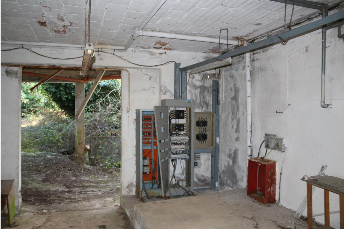
FOTO n°9. - visione interna immobile – corpo principale
