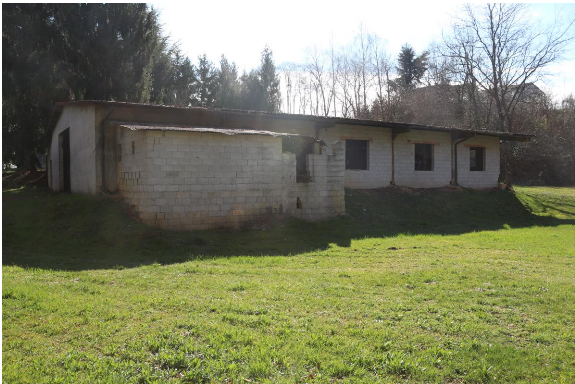
FOTO n°20. - visione esterna immobile – corpo staccato
