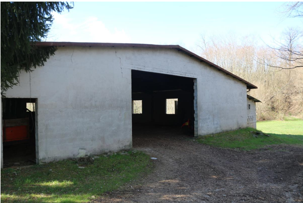
FOTO n°18. - visione esterna immobile – corpo staccato
