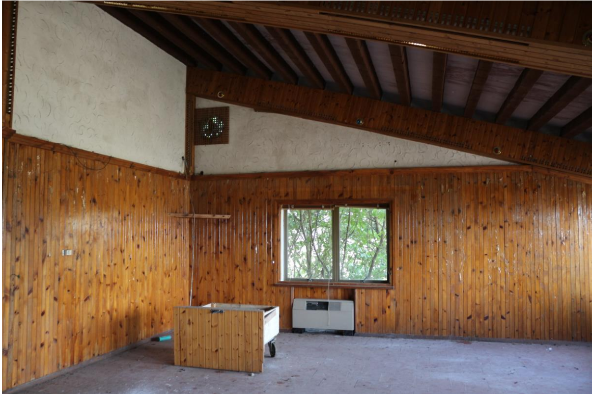
FOTO n°13. - visione interna immobile – corpo principale
