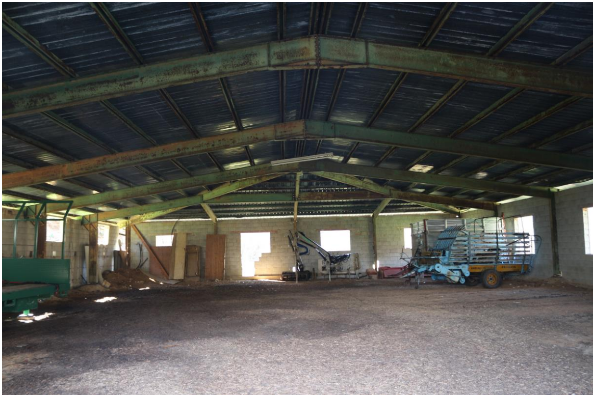
FOTO n°19. - visione interne immobile – corpo staccato
