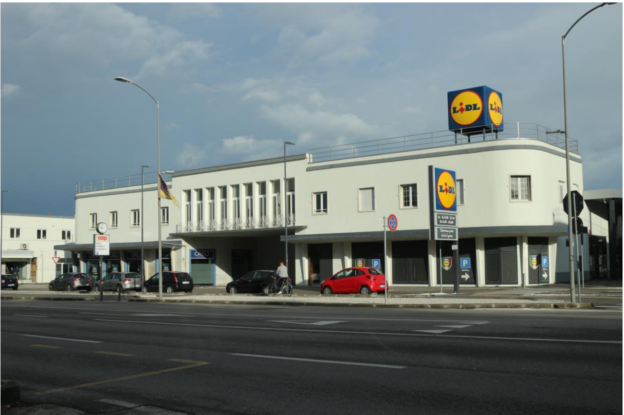
FOTO n°12. - visione esterna – LOTTO 9.3
