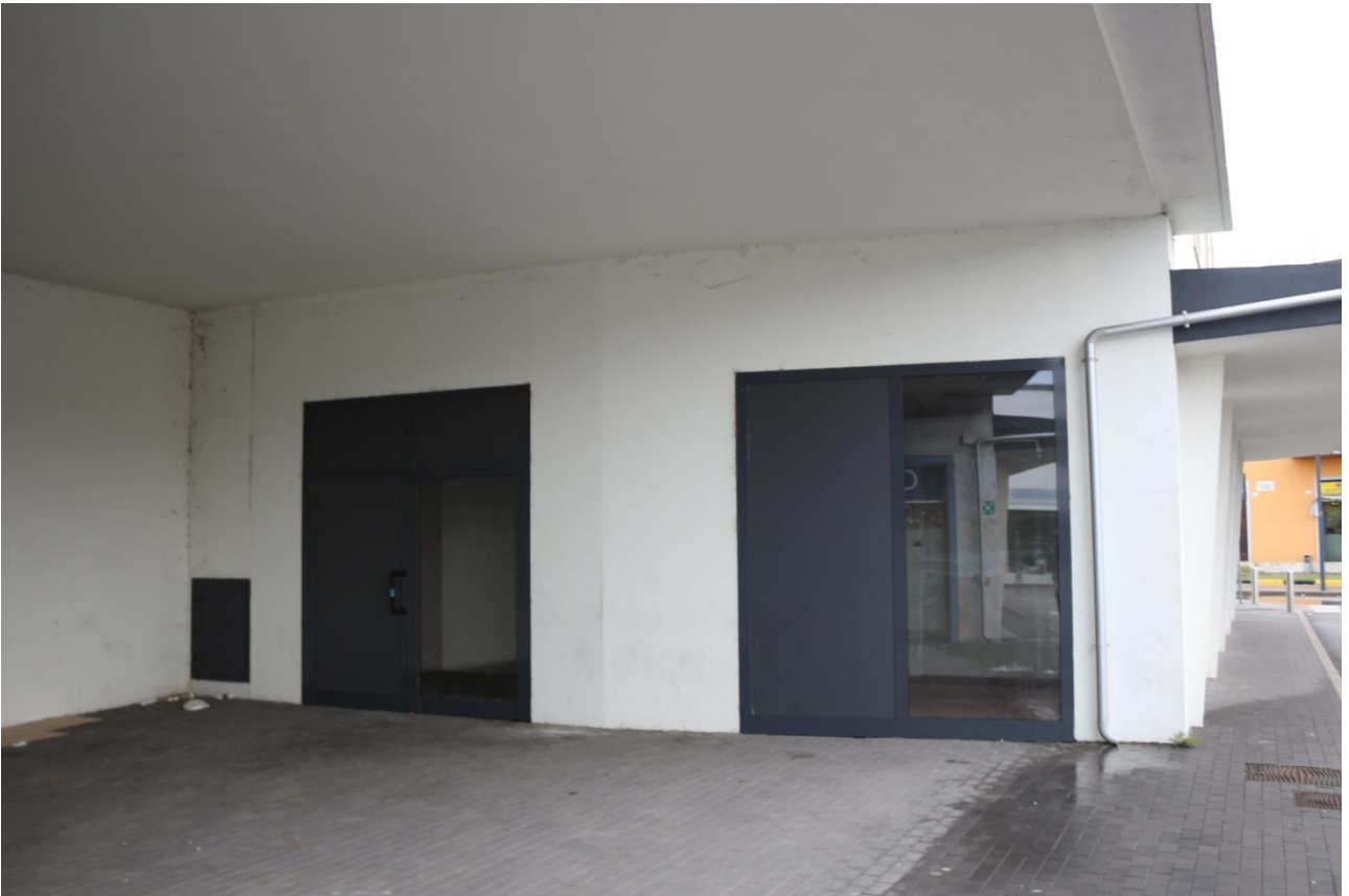
FOTO n°13. - visione esterna – LOTTO 9.3
