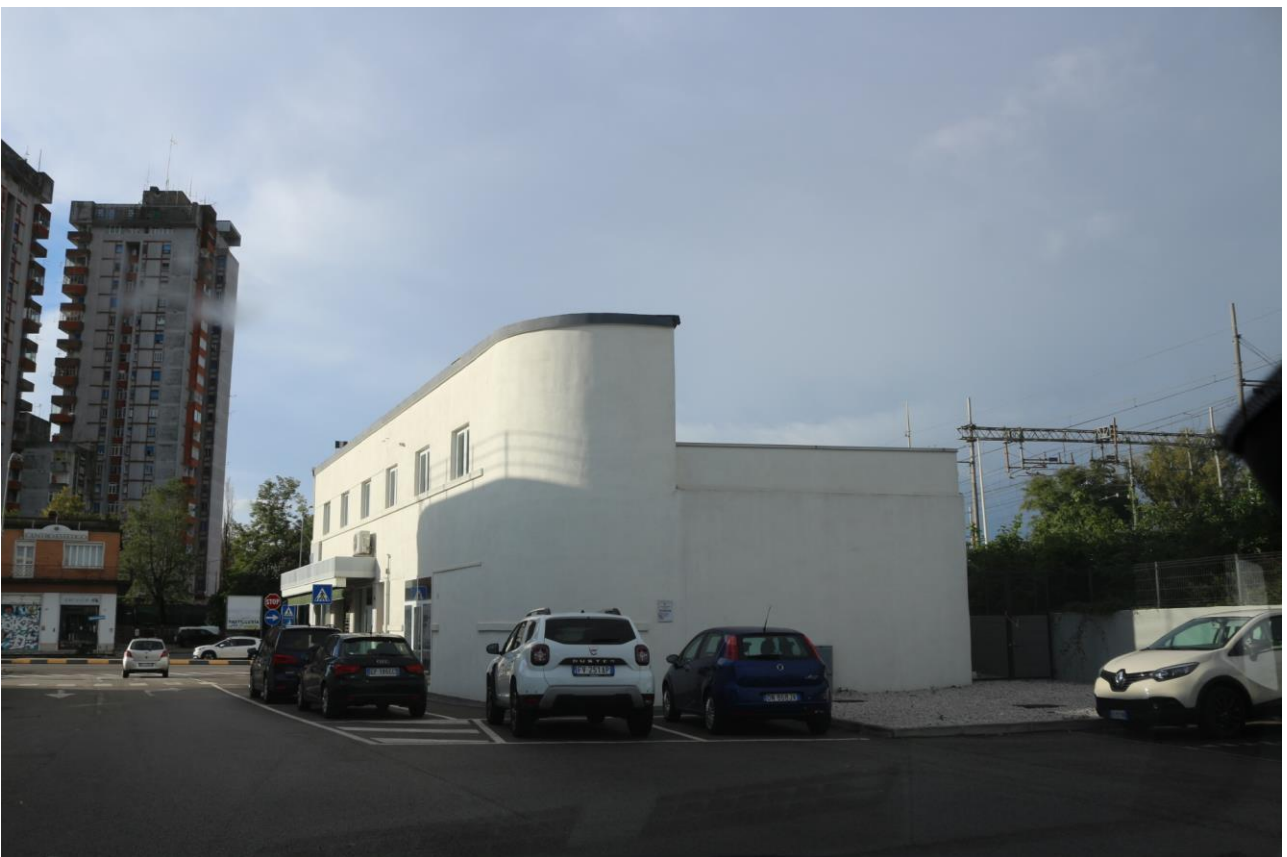
FOTO n°2. - visione esterna – LOTTO 9.1
