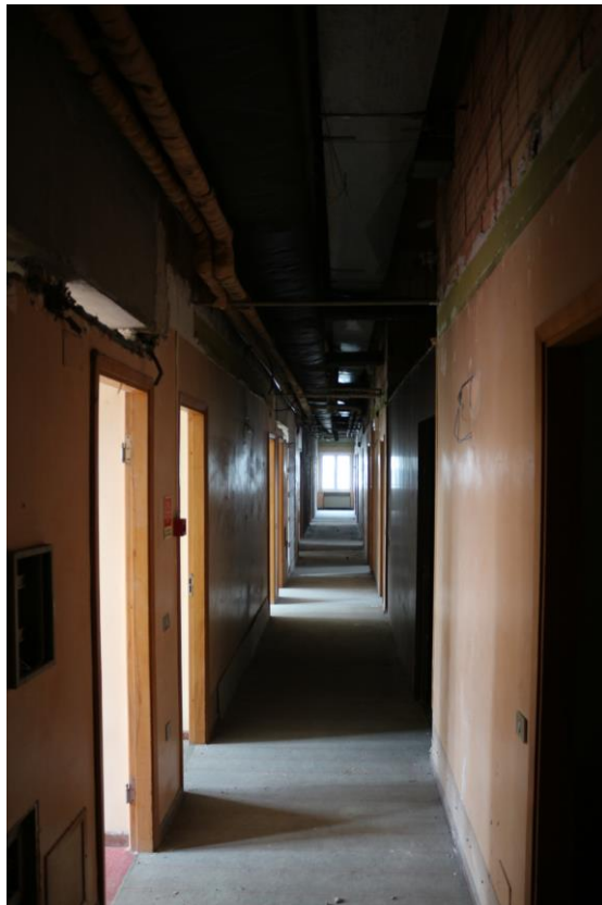
FOTO n°16. - visione interna – LOTTO 9.3
