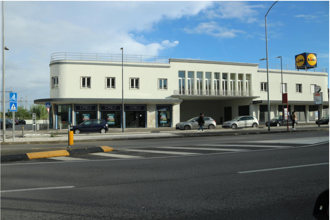
FOTO n°11. - visione esterna – LOTTO 9.3
