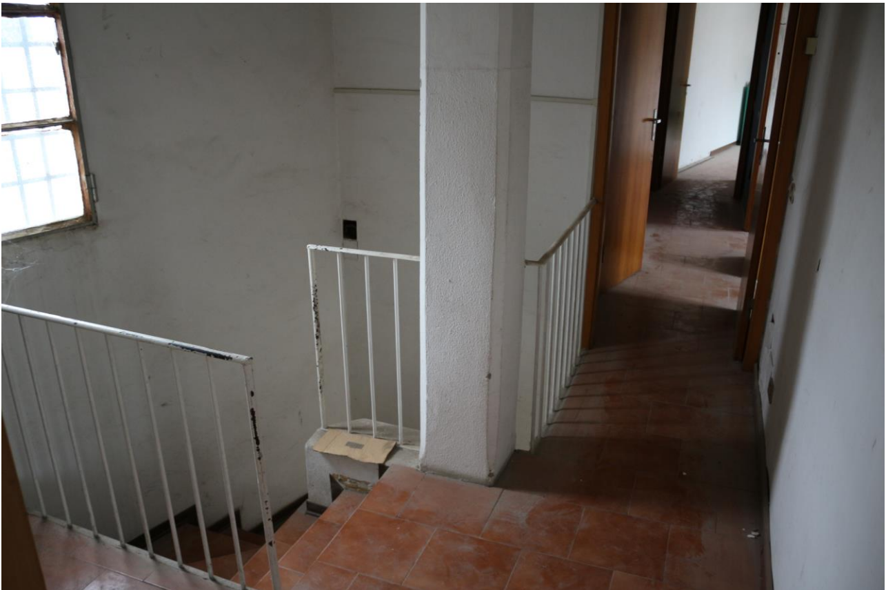
FOTO n°4. - visione interna – LOTTO 9.1
