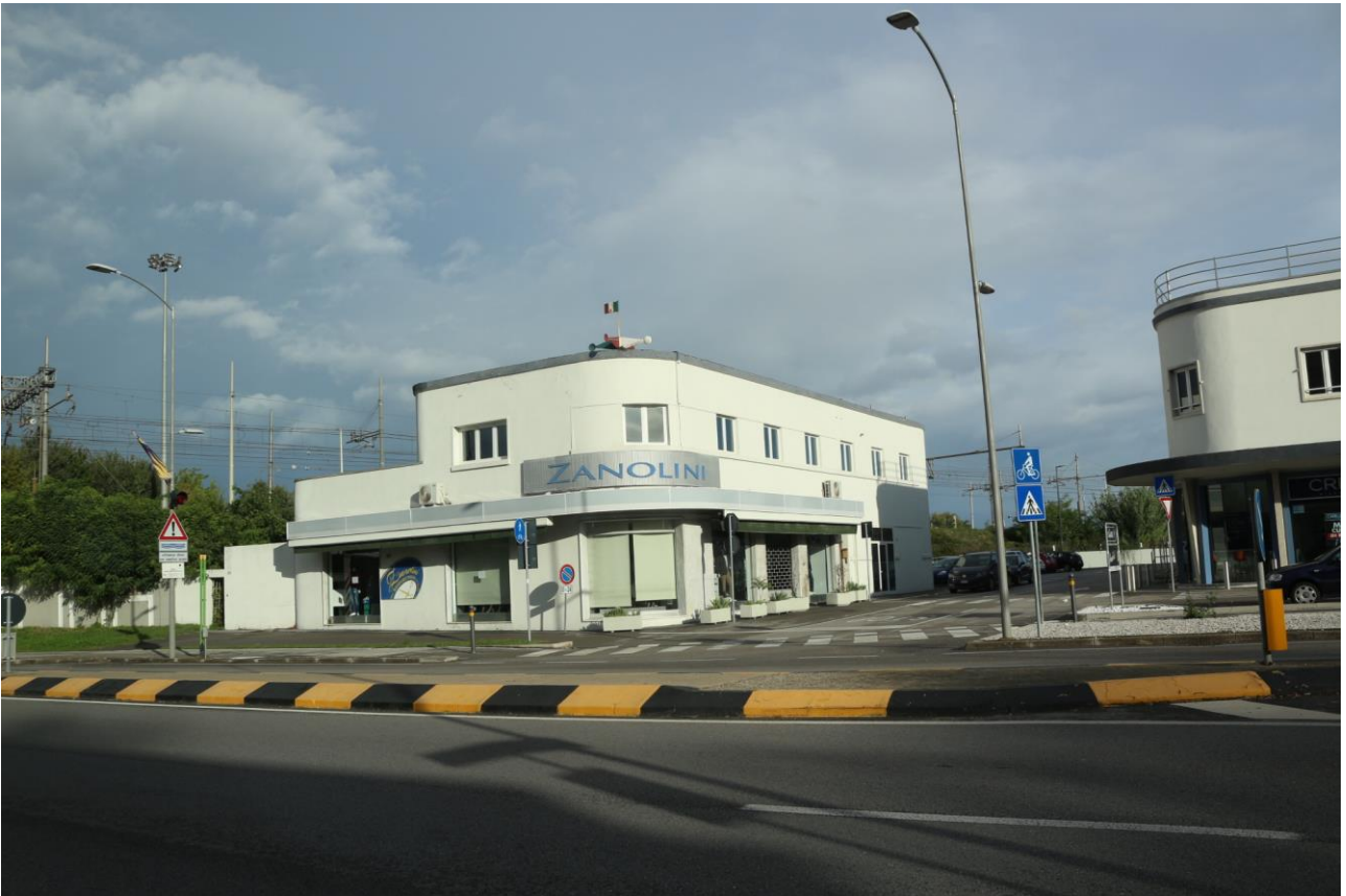
FOTO n°1. - visione esterna – LOTTO 9.1
