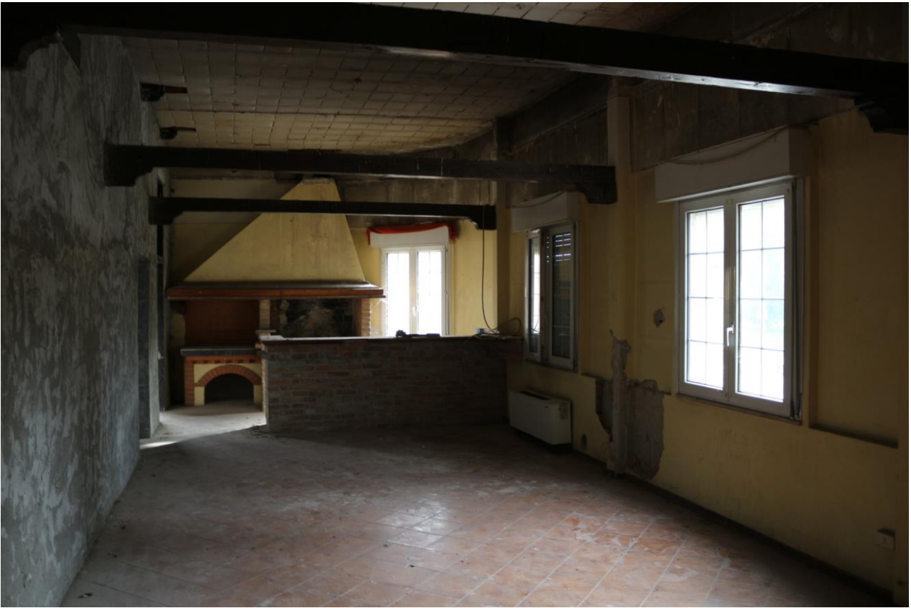
FOTO n°17. - visione interna – LOTTO 9.3
