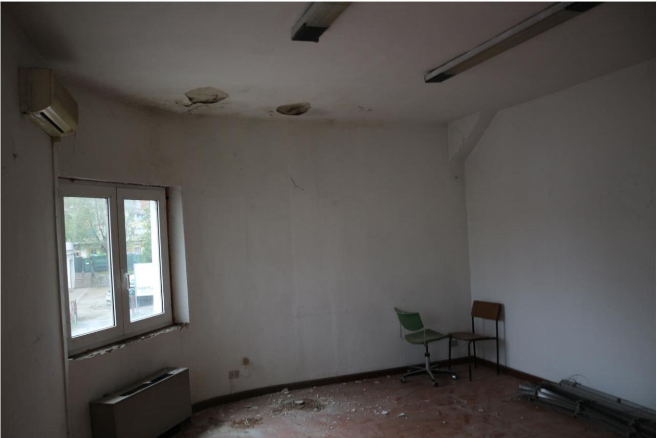
FOTO n°7. - visione interna – LOTTO 9.1
