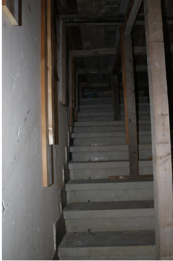
FOTO n°21. - visione scala di accesso alla copertura – LOTTO 9.3
