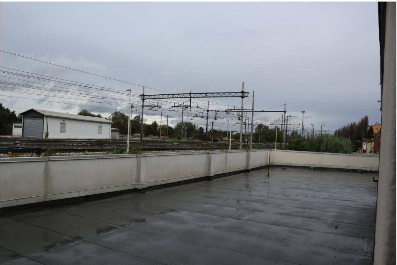
FOTO n°10. - visione lastrico solare – LOTTO 9.1
